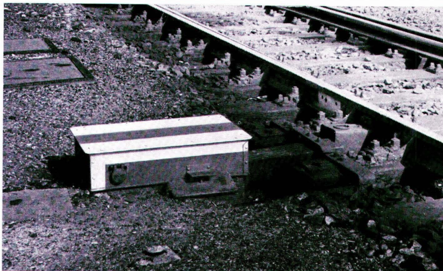
Abb. 17: Warnanstrich an Schutzkästen von Weichenantrieben und Riegeln (zu Abschn. IV/3)
