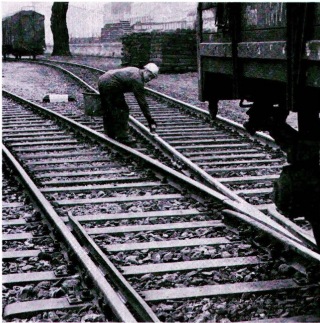
Abb. 11: Hemmschuh zu spät aufgelegt — falsch
