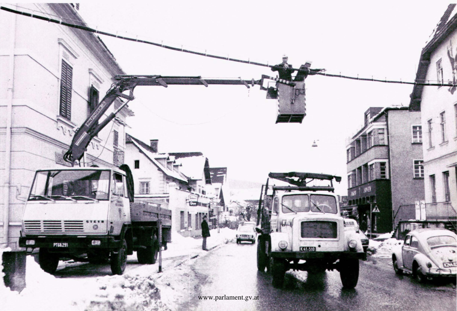
▲ Bild 21 Arbeiten an einer Fernmelde-Luftkabelleitung im Jahre 1951 — und mit modernen Arbeits- und Arbeitsschutz- ▼ Bild 22 mitteln ein Vierteljahrhundert später.
