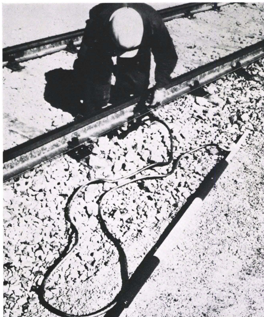
Anschließen der Erdungsklemme an die Schiene
