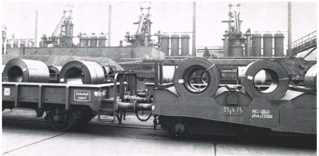
Abb. 14: Spezialtransportwagen im Werksverkehr vor den Hochöfen
