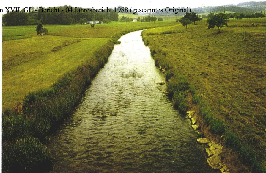
Melk im Bereich von St. Leonhard nach der Revitalisierung
