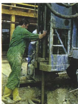
Mit dem Spülbohrverfahren bis in 100 Meter Tiefe
