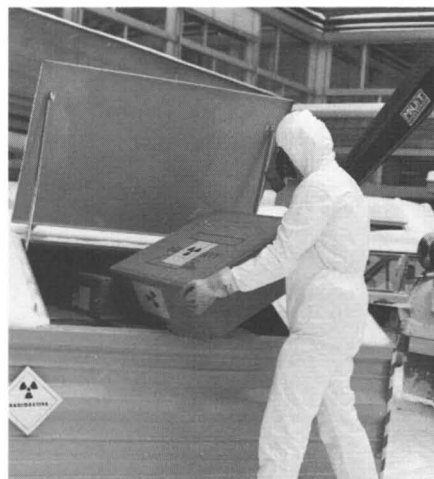
Filtereinsätze in Lüftungsanlagen von Telephonzentralen werden gewechselt
