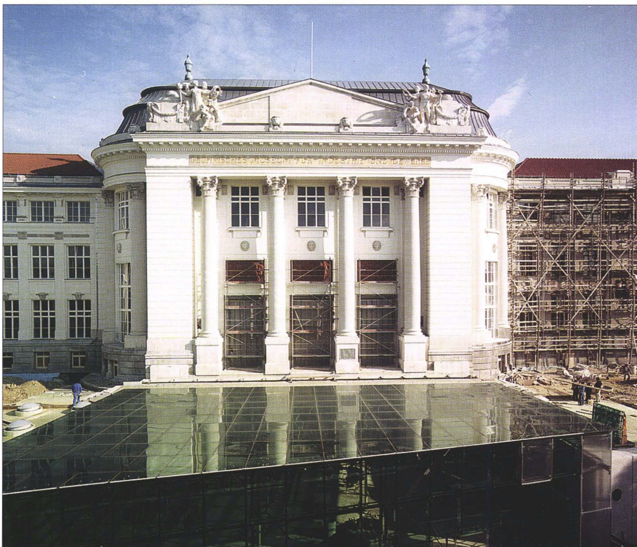
Mittelrisalit mit noch im Bau befindlicher neuer Eingangsballe, Oktober 1996
