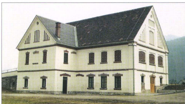
Zellach, ehem. Wirtschaftsgebäude
