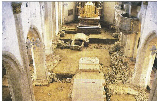
Aspach, OÖ, Kirche, Fundamente des römischen Vorgängerbaues
