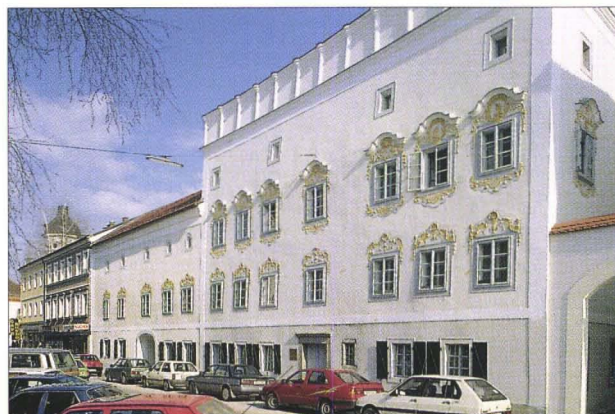
Grieskirchen, Prechtlerstraße Nr. 18
