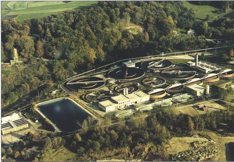
Abb. 2.3: Kläranlage Lenzing AG
