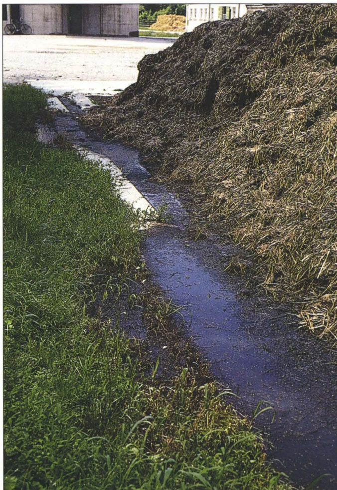
Abb. 7.1: Miststapel ohne ausreichende Sickerwasserfassung
