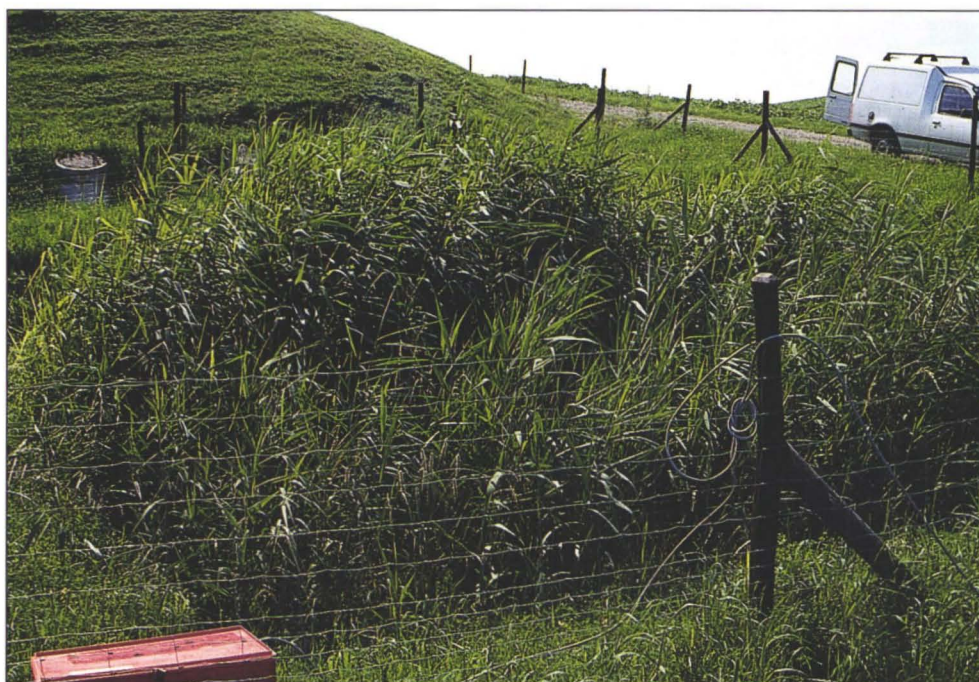
Abb. 2.7: Pflanzenkläranlage - Pilotanlage Wolfers/OÖ, in Betrieb
