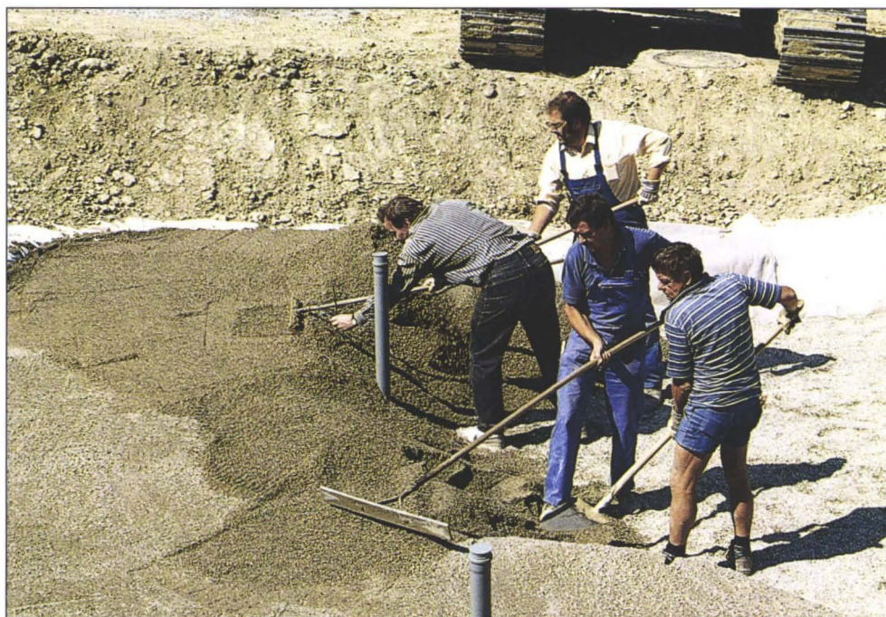
Abb. 2.6: Pflanzenkläranlage - Pilotanlage Wolfers/OÖ, in Bau
