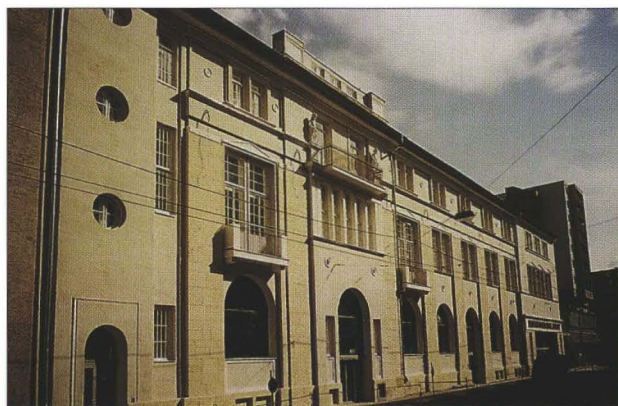
Abb. 1: Salzburg, ehemalige Brotfabrik, Fassade nach Instandsetzung
