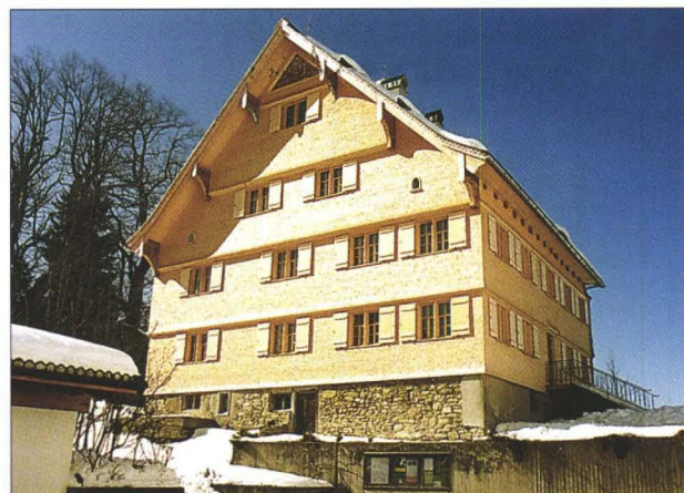
Abb. 3: Sulzberg, Pfarrhof, nach Restaurierung
