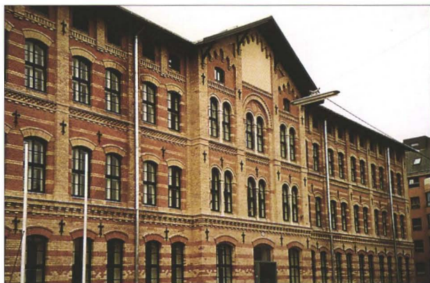
Abb. 1: Wien 19., Bachhofengasse 8, Fabriksgebäude nach Sanierung
