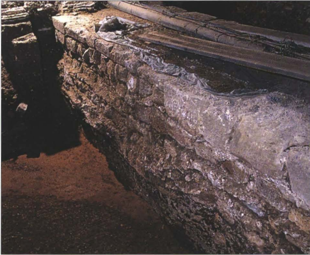
Abb. 4: Wien, Stephansdom, dreiphasiges Nordfundament der romanischen Basilika
