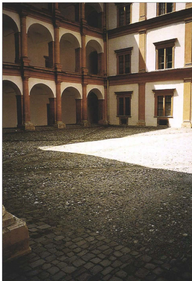
Abb. 2: Graz, Schloss Eggenberg, Innenhof nach Absenkung auf das ursprüngliche Niveau und Pflasterung mit „Murnockerl“
