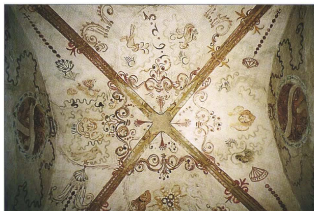
Abb. 1: Fernitz, Pfarr- und Wallfahrtskirche Mariatrost, Blick in das Gewölbe der Nordturmchamber mit den restaurierten Wandmalereien
