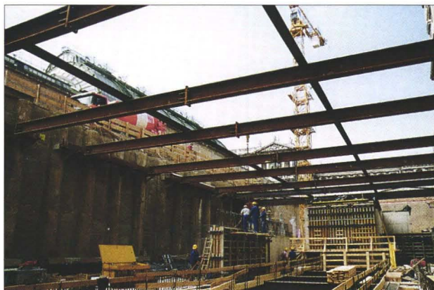
Der Tiefspeicher wird errichtet – das Herzstück wird das autom. Hochregallager sein, welches ca. 90% der Sammlungen aufnehmen wird.
