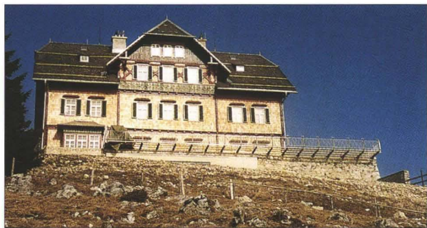
Abb. 5: St. Radekund, Schöckl, Stubenberghaus, Südansicht nach der Sanierung
