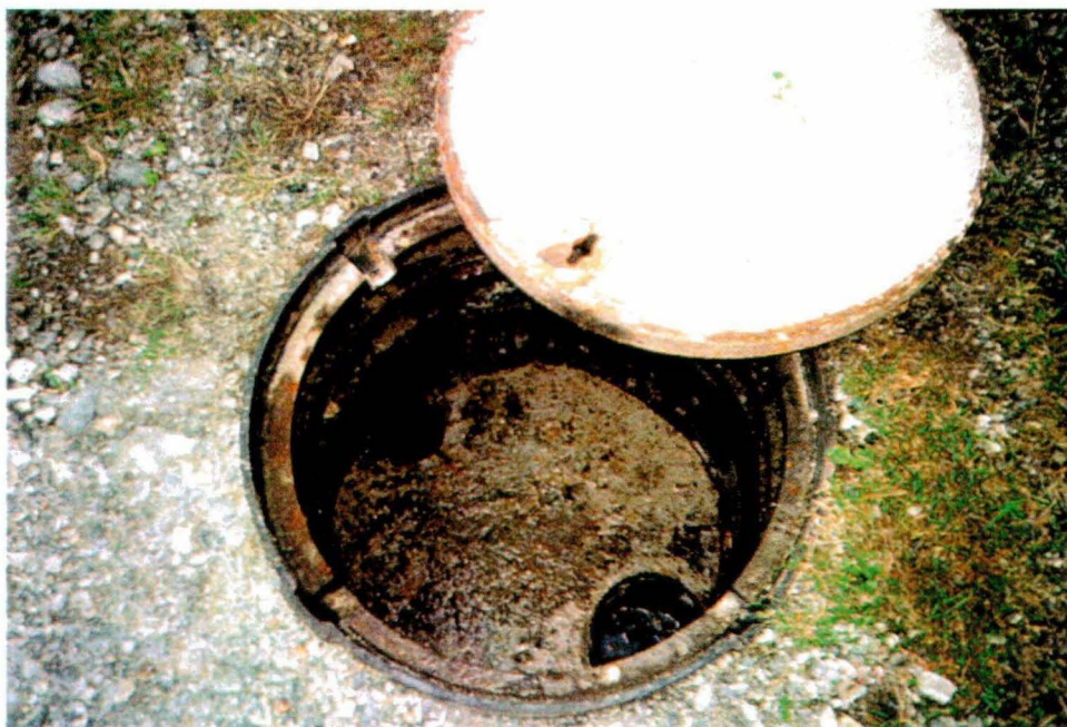
Abb. 32: Fettabscheider vor dem Abschöpfen der Schwimmstoffe
