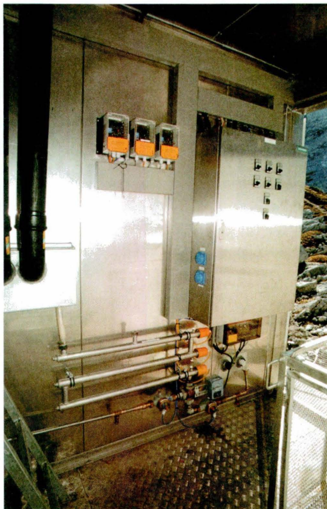
Abb. 61: Container „Technik“: UV-Filteranlage
