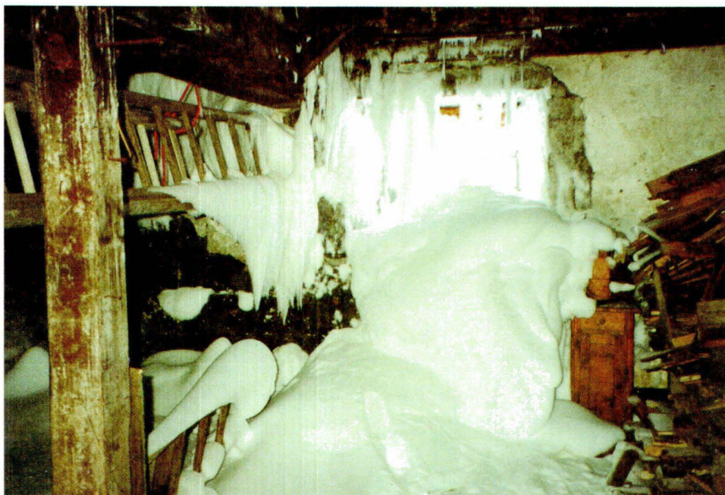
Abb. 53: Schneeintrag in den nicht nutzbaren Räumen
