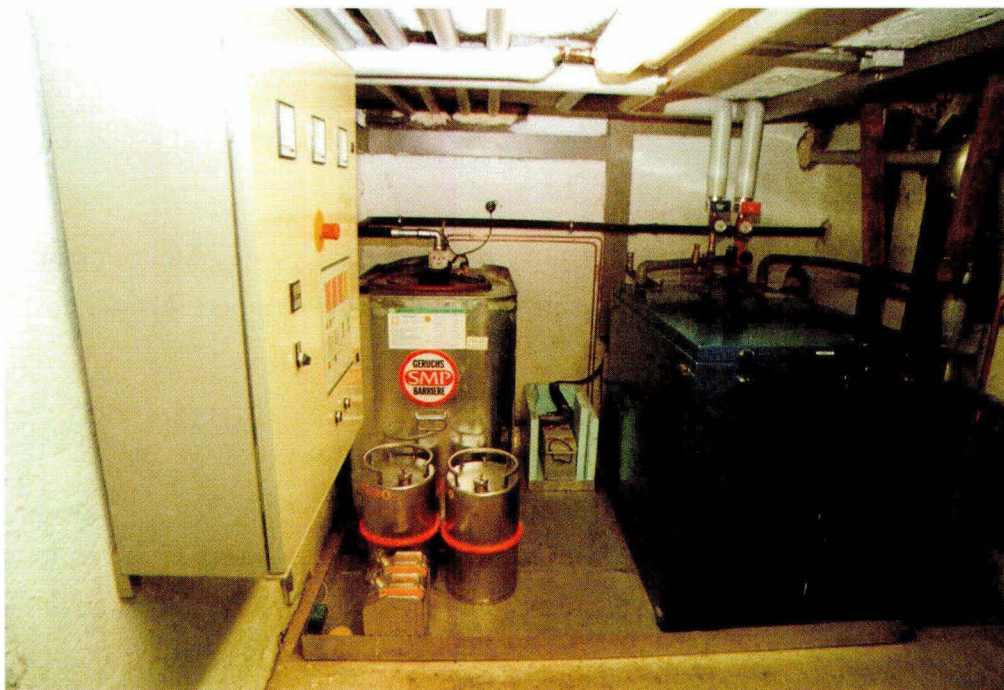
Abb. 57: Blockheizkraftwerk, doppelwandiger Tank, dichte Auffangwanne
