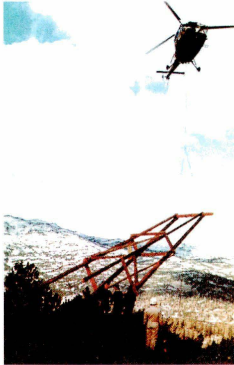
Abb. 115: Bau der Materialseilbahn: Hubschraubertransport
