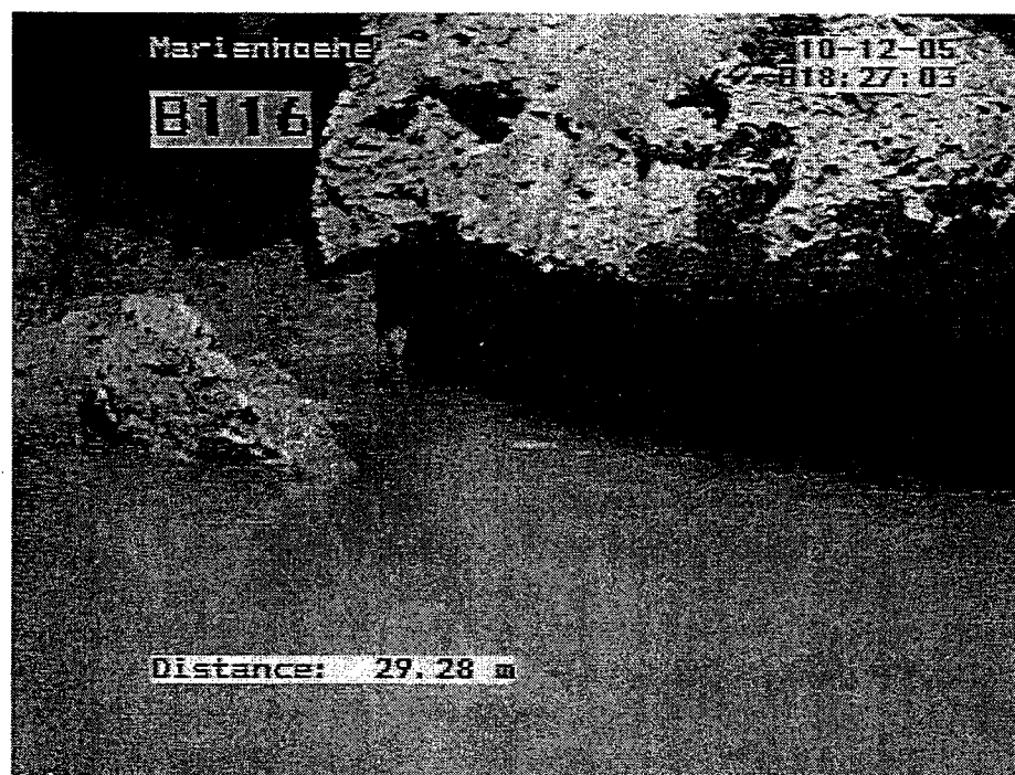
Abb. 8: Blockartiger Nachbruch auf wasserbedeckter Sohle
