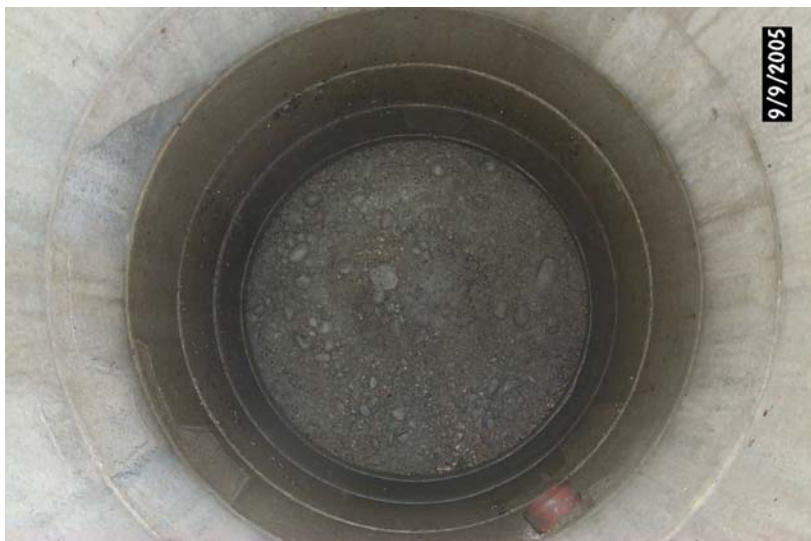
Abb. 2: Versickerungsschacht auf 845/6 KG Maria Enzersdorf
