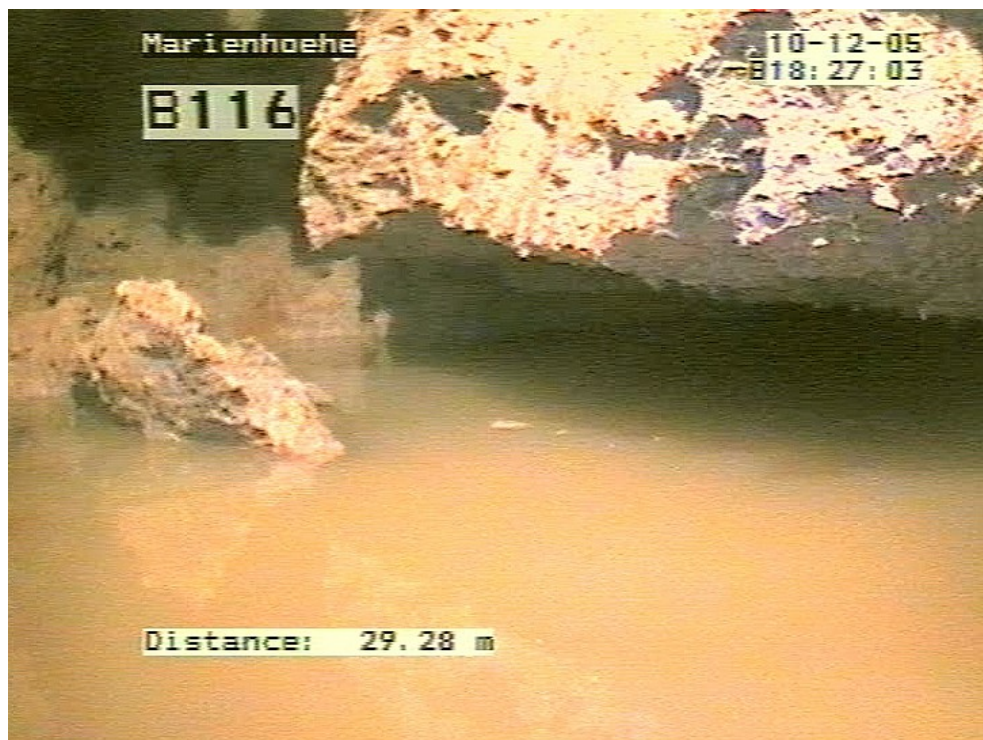
Abb. 8: Blockartiger Nachbruch auf wasserbedeckter Sohle
