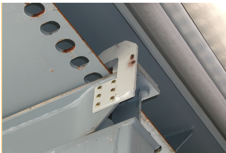
Sicherung der Aufhängeeinrichtung
