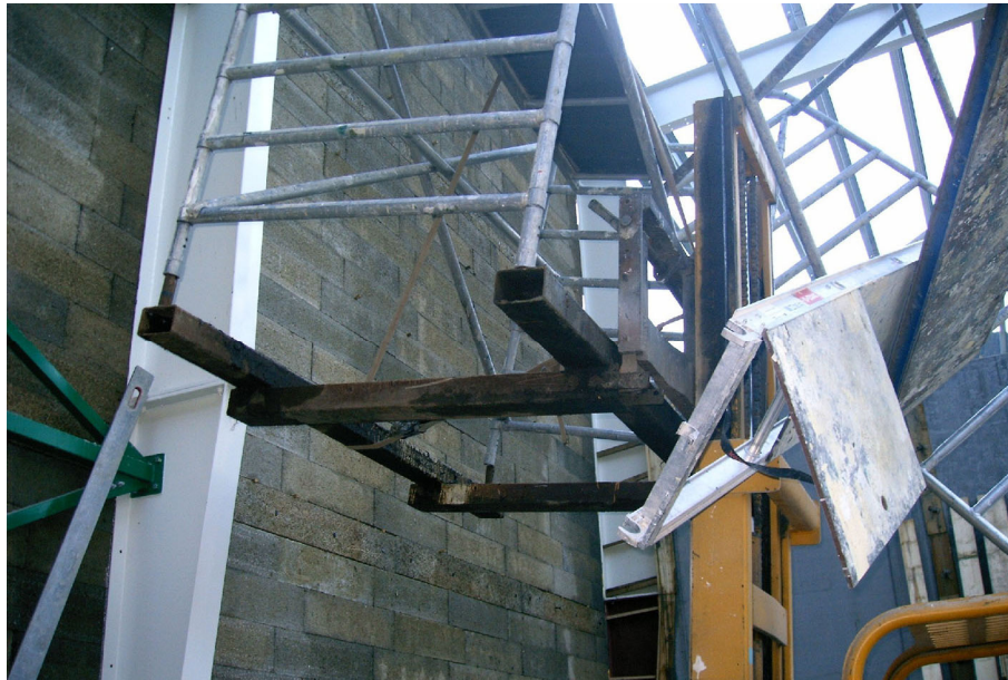
Hubstapler mit „Hilfskonstruktion“
