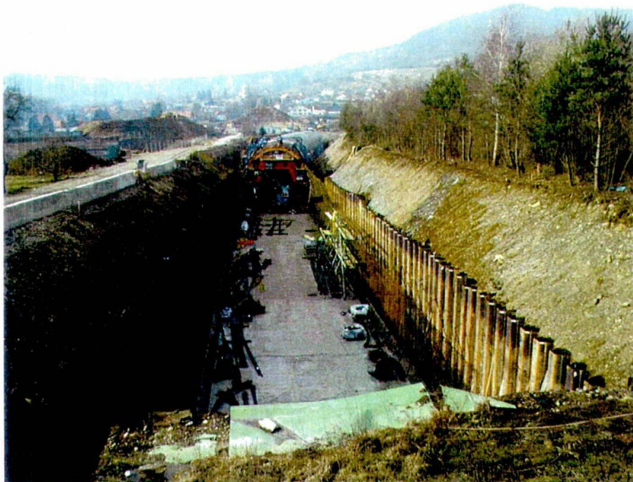
Südbaulos – offene Bauweise
