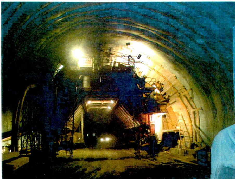
Südbaulos – untertägiger Bauabschnitt
