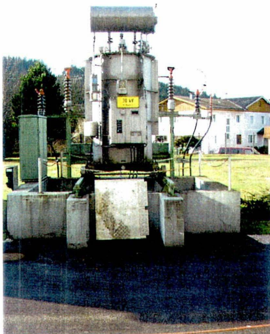
Erdschlusslöschspule
