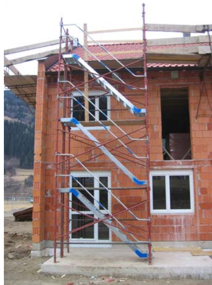
Treppenturm als optimaler Verkehrsweg
