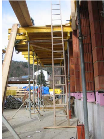
Leiter optimal aufgestellt und ordnungsgemäß gesichert
