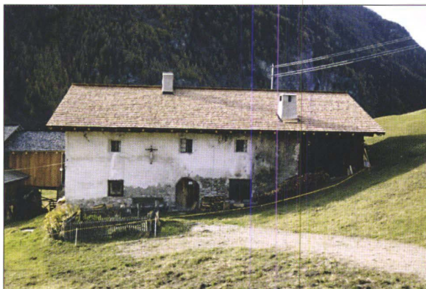
Abb. 1: Apriach, Unterfreser. Wohnbaus nach Neueindeckung
