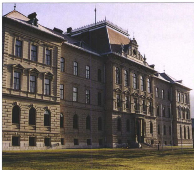
Abb. 5: St. Paul im Lavanttal, Stiftsgymnasium, nach Außenrestaurierung
