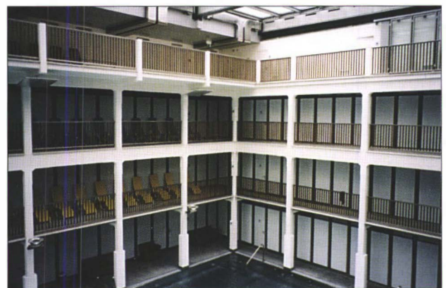
Abb. 2: Graz, Bad zur Sonne, Freibecken mit der Stahlbetonkonstruktion
