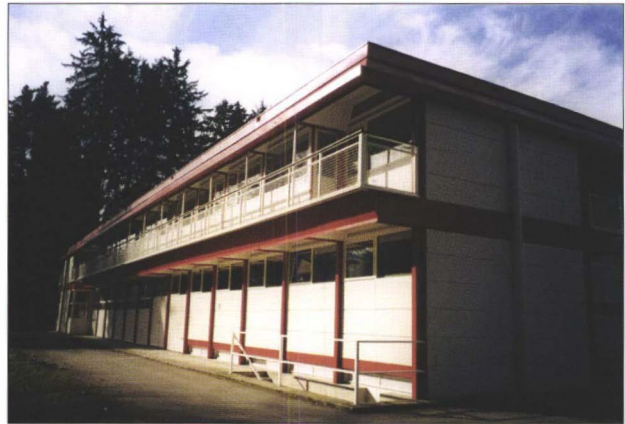
Abb. 2: Salzburg, Kolleg St. Josef, Außenansicht nach Restaurierung
