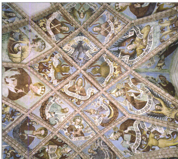
Abb. 4: Klagenfurt Viktring, Bernhardkapelle, spätgotische Fresken im Gewölbe
