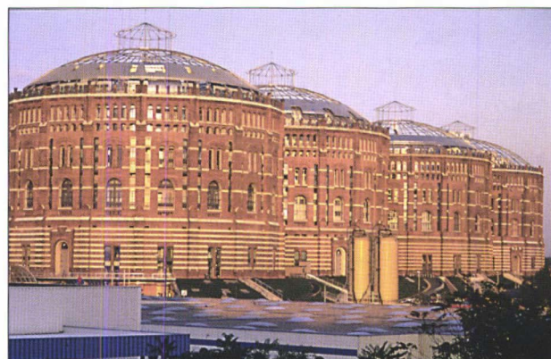
Abb. 1: Wien 11., Gasometer, nach Sanierung
