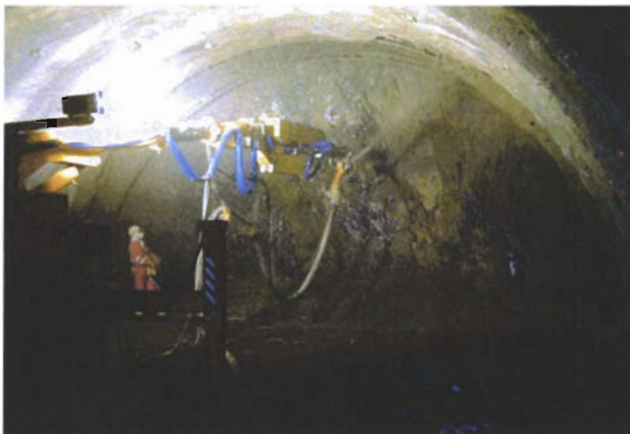
Einsatz von Manipulatoren beim Nassspritzverfahren
