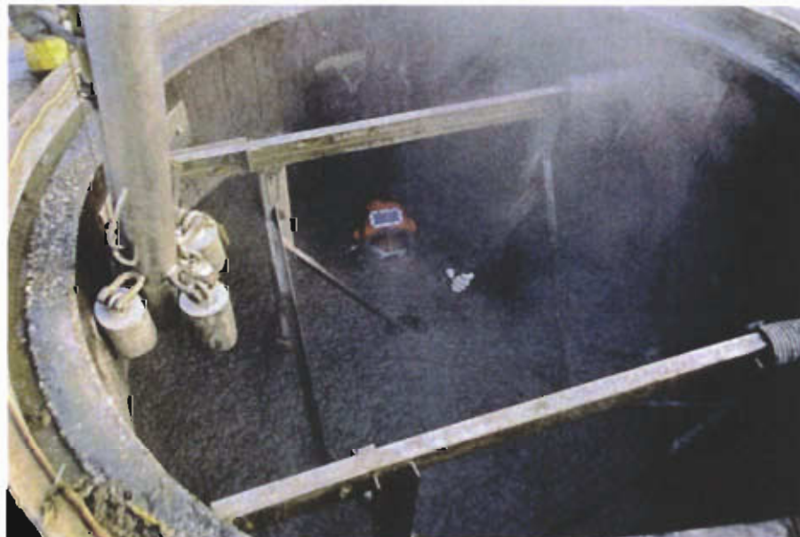
Tauchereinsatz bei der Faulturmreinigung
