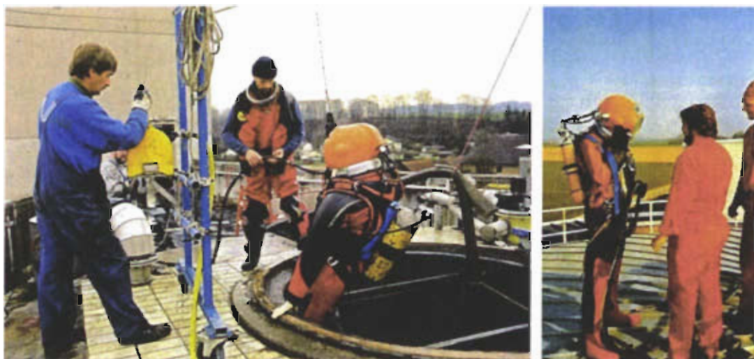
Mannschaft zum Reinigen der Faultürme
