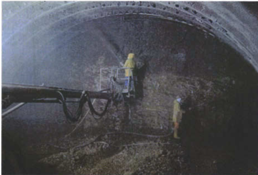
Düsenführer beim Trockenverfahren
