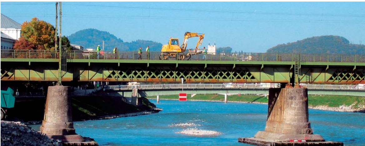
Neubau der Salzach-Brücke in Salzburg
