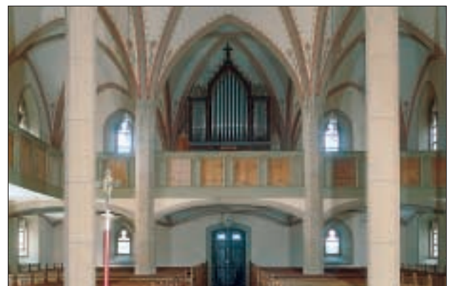
Abb. 4: Hargelsberg, Pfarrkirche, Wiederherstellung der neugotischen Raumfassung
