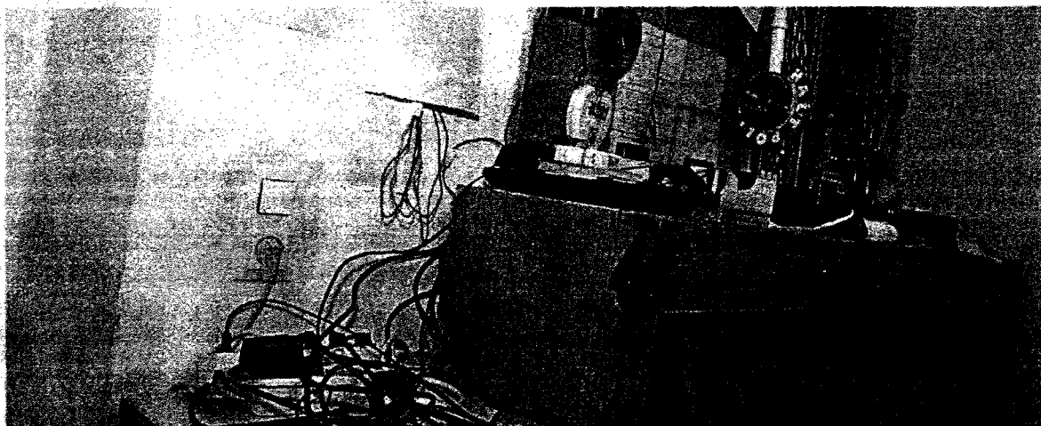
Desolates Wachzimmer in Wien: In der Vergangenheit halfen die Polizeifreunde bei der Renovierung. Künftig muss das Innenministerium zahlen. (©Gerald Feber)
