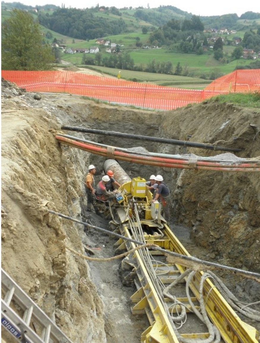
Nachrüstung des Gasfernleitungsnetzes in Slowenien zwischen der slowenisch-österreichischen Grenze und Ljubljana
