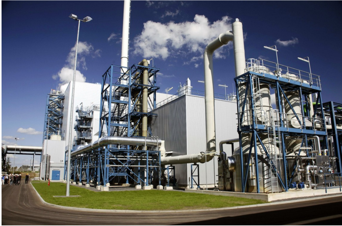
CCS-Pilotanlage in Jämschwalde, Deutschland
