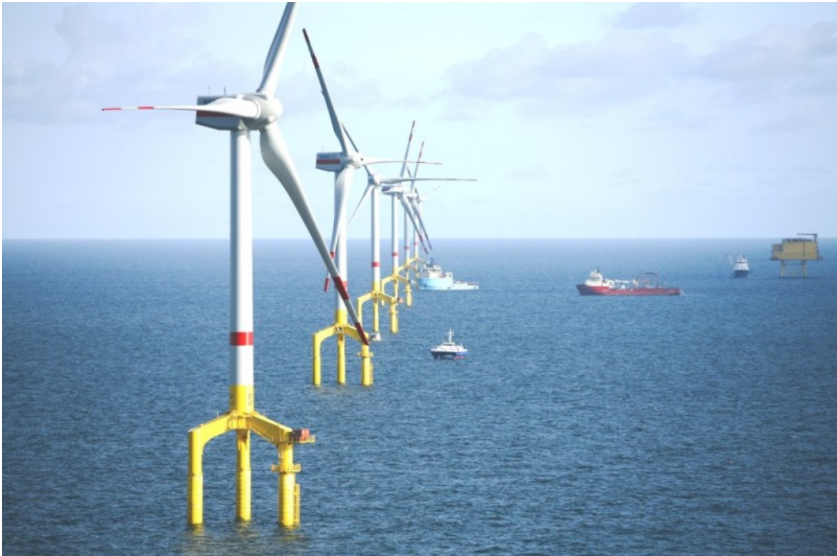
Multi-MW-Turbinen und Offshore-Fundamentstrukturen in der Anlage Bard I in der deutschen Nordsee, kofinanziert vom EEPR
