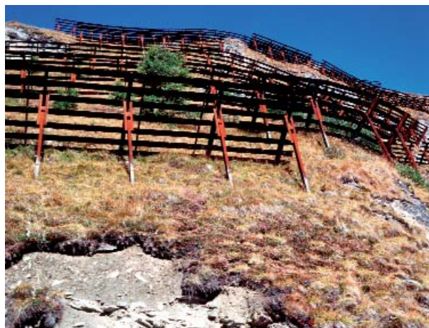
Lawinerverbauung in alpinem Gelände ist eine wichtige Maßnahme zur Vermeidung von Naturgefahren.
