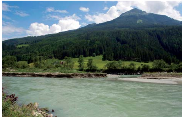
Hochwasserschutz Salzach Bramberg
