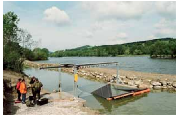
Fischaufstiegshilfe beim Kraftwerk Melk - Funktionskontrolle
