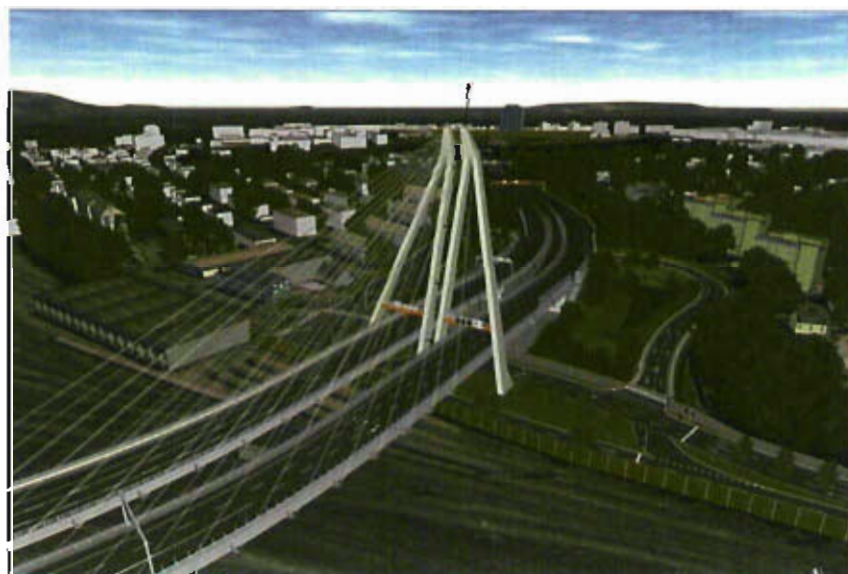
Abbildung 5: Westbrücke mit Blickrichtung zum Anschluss A 7 (Verwirklichungsabschnitt 3)
