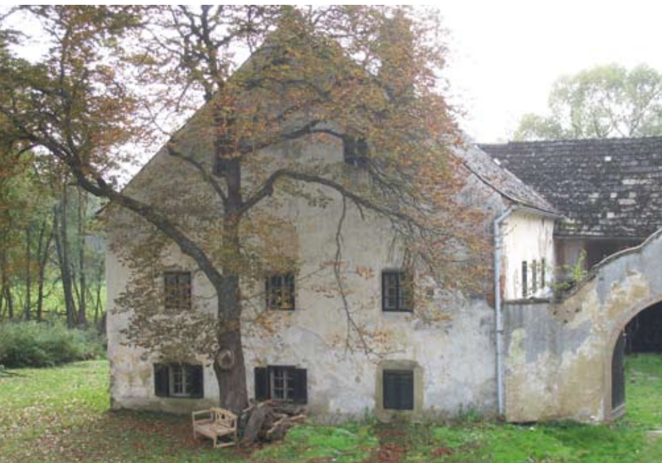
Schwarzenau, Stögersbach 43, Neumühle, Ansicht von Norden, © BDA
