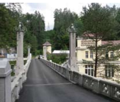
Molln, Kraftwerk Steyrdurchbruch, © B. Gasché
