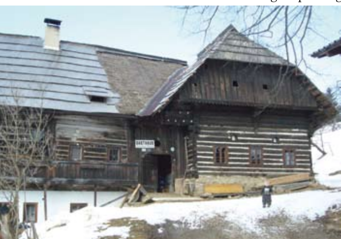
St. Leonhard an der Saualpe, Gehöft, nach der Teil-Neueindeckung, © BDA
