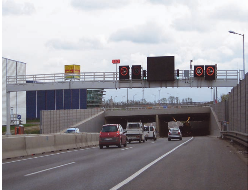
S 1 Wiener Außenring Schnellstraße – Errichtung und Bauweise: Österreichische Autobahnen- und Schnellstraßen Aktiengesellschaft (ÖSAG) bzw. ASFINAG Bau Management GmbH Bild: Rechnungshof
