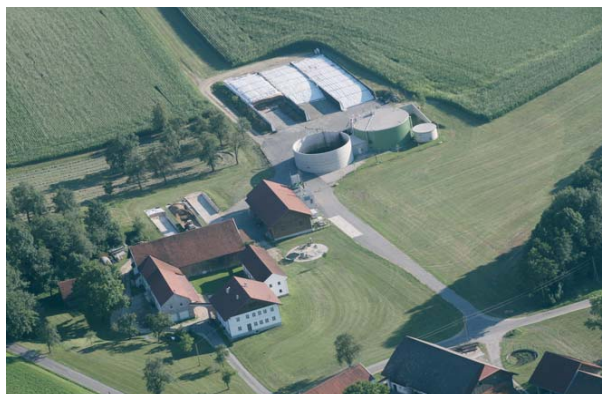
Biogasanlage in Mehrnbach, Oberösterreich, Agrar Portal
