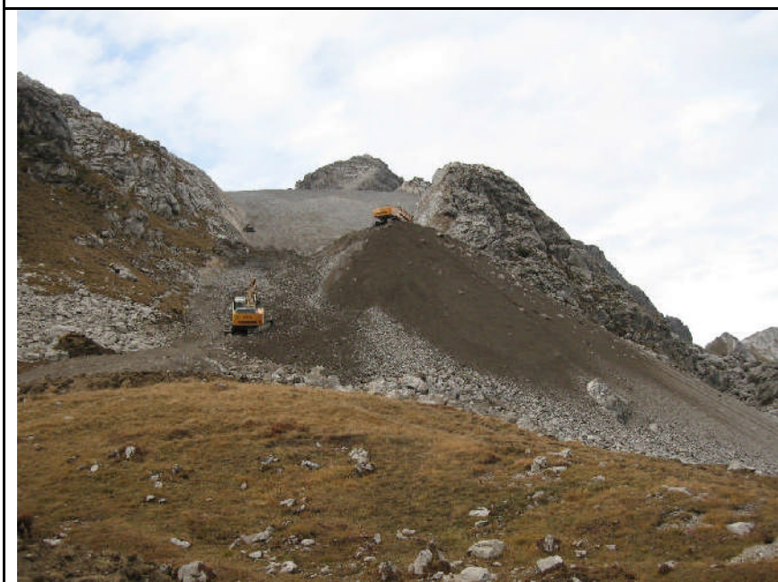
Bild 7 Felsabtrag Bereich Steinmäder nach dem Starthang
