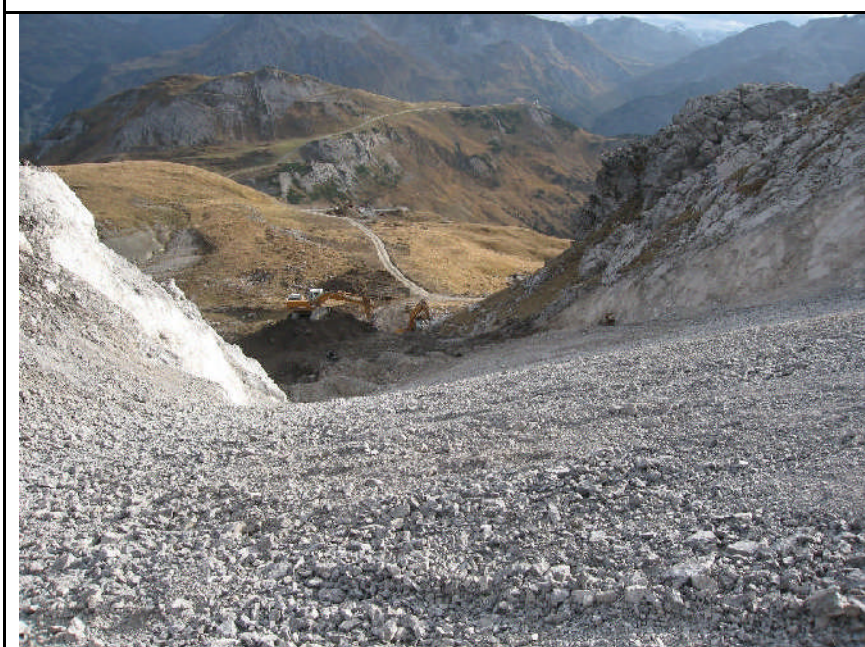
Bild 8 Felsabtrag Bereich Steinmäder nach dem Starthang
