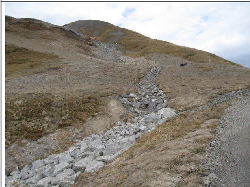
Bild 4 Sulzen- Grobsteinauskleidung mit Drainagerohr
