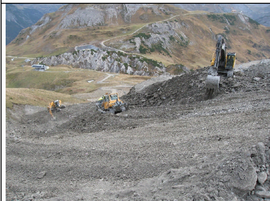
Bild 5 Bereich Sulzen/ Abtrag und Einbau
