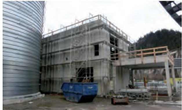
Bau der Maschinenhalle für die Abwasserreinigung
