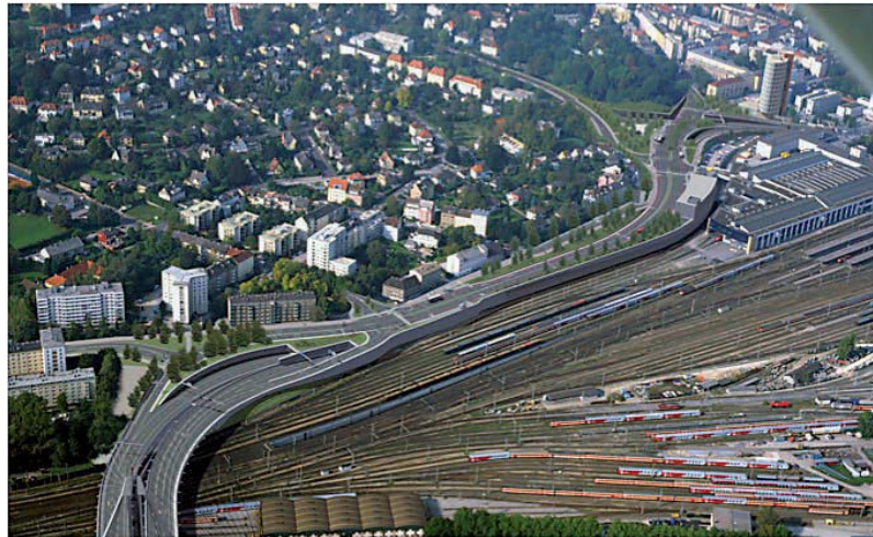
Abbildung 4: Abschnitt Unterflurstraße Waldegg bis Anschlussstelle Bahnhof (Verwirklichungsabschnitt 2)
