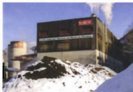
Mayr-Melnhof Biomassekraftwerk Leoben GmbH
