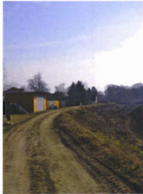
Linkes Ufer mit zukünftiger Damms-trasse, gerinneabwärts der Straßenbrücke (L167)
