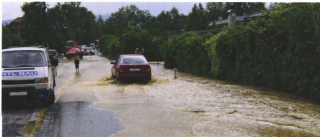
Überflutung der Hitzendorferstraße
