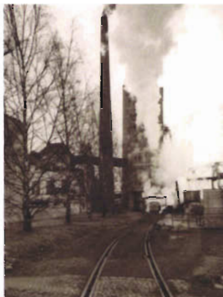
Ehemaliges Gaswerk Rudersdorf, Aufnahme vermutlich um 1950.
