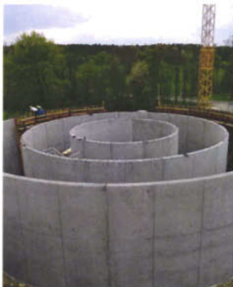
Bau der biologischen Abwasserreinigung
