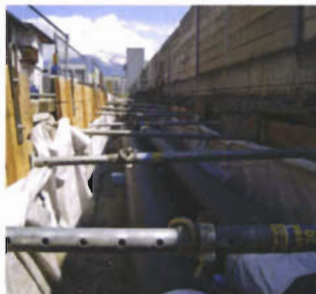
Wärmeleitungsstrasse, Rohrverlegung
