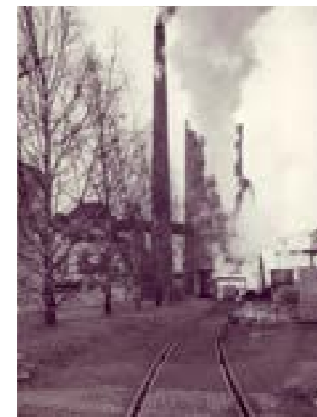
Ehemaliges Gaswerk Rudersdorf, Aufnahme vermutlich um 1950.
