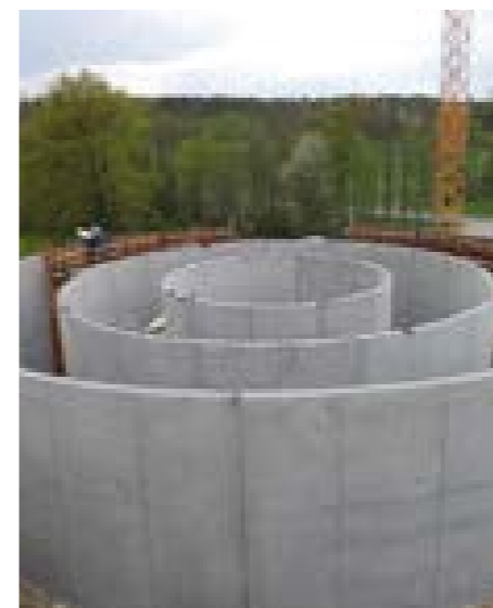
Bau der biologischen Abwassereinigung
