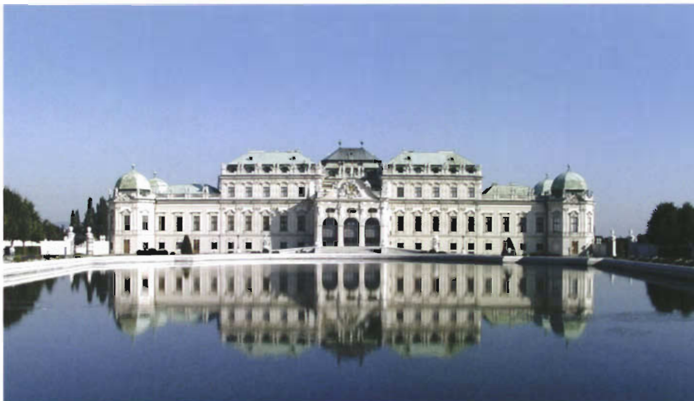
Außenansicht Oberes Belvedere © Belvedere
