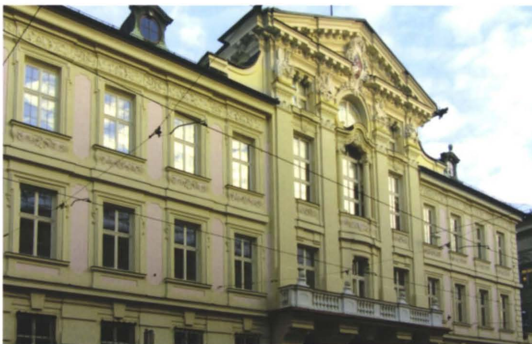
Innsbruck, Maria-Theresien- Straße 43, Landhausfassade © BDA / Hauser
