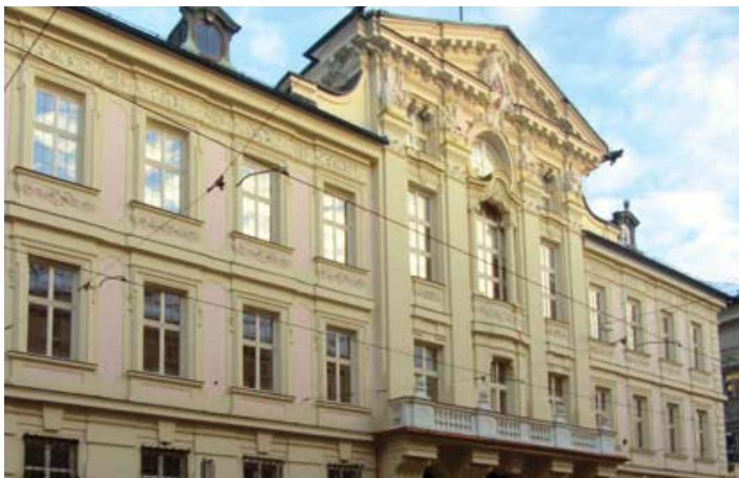
Innsbruck, Maria-Theresien-Straße 43, Landhausfassade © BDA / Hauser
