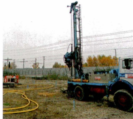
Errichtung der Belüftungsanlagen für die in-situ-Sanierung
