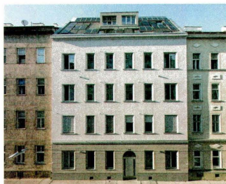
Sanierung Gründerzeitgebäude Vergleich vorher/nachher
