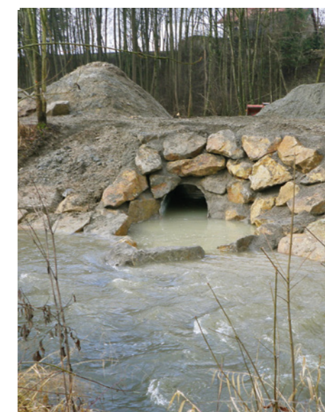
Mündung des neuen Rottenbaches mit Durchlass Sohlebene Anbindung an die Trattnach
