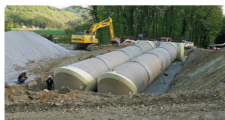
Oben: Transport der Fertigteile für den Hochbehälter Mitte: Versetzen der Fertigteile für den Hochbehälter Unten: Fertigstellung Hochbehälter Thal
