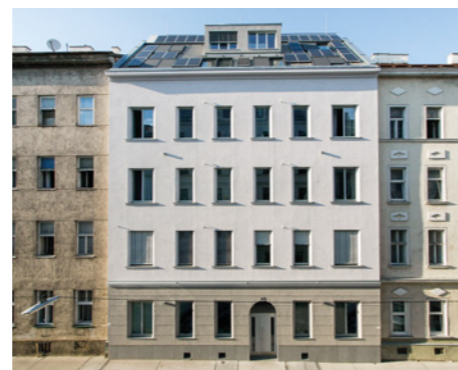
Sanierung Gründerzeitgebäude Vergleich vorher/nachher
