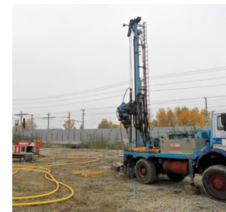
Errichtung der Belüftungsanlagen für die in-situ-Sanierung
