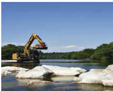
2016 wurden 90,9 Mio. Euro für Maßnahmen des Schutzwasserbaues aufgewendet. Im Bild: Schutzmaßnahmen an der Traisen.
