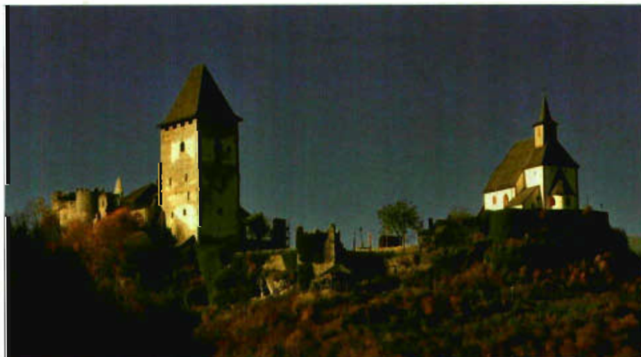
Friesach, Petersberg, Restaurierung des romanischen Bergfrieds © Verschönerungsverein Friesach 2012
