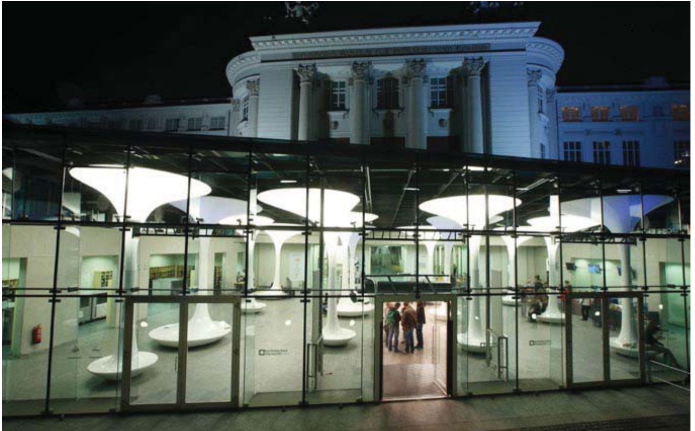
TMW Außenansicht © TMW
