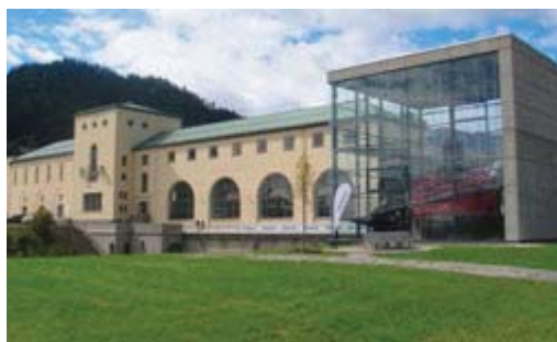
Pernegg, Kraftwerk nach Umbau und Restaurierung, im Vordergrund die Schauturbine © BDA
