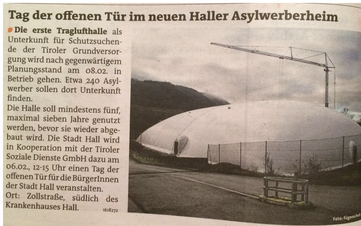
Erste Traglufthalle als Asylunterkunft (Hall in Tirol)
