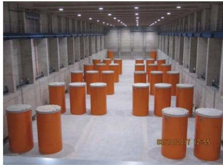
Die Hauptleistung ist die Entfernung der abgebrannten Brennelemente aus den Reaktorgebäuden. Dieser Prozess begann im vierten Quartal 2016 und verlief planmäßig; er konnte früher abgeschlossen werden, ohne die Betriebssicherheit zu gefährden. Das Bild zeigt die gelagerten Behälter mit abgebrannten Brennelementen im neuen Zwischenlager im Oktober 2017.
