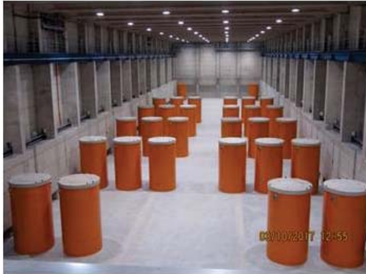
Abbildung 5 — Lagerung der Behälter.
