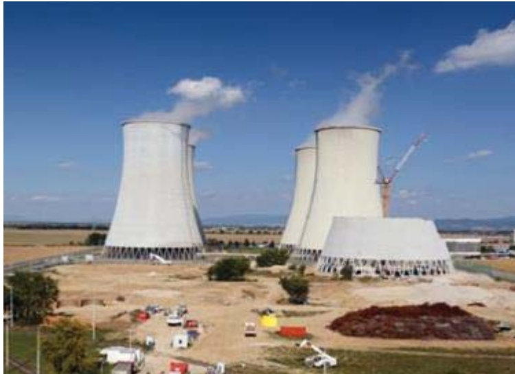
Abbildung 3 — Abriss der Kühltürme.
