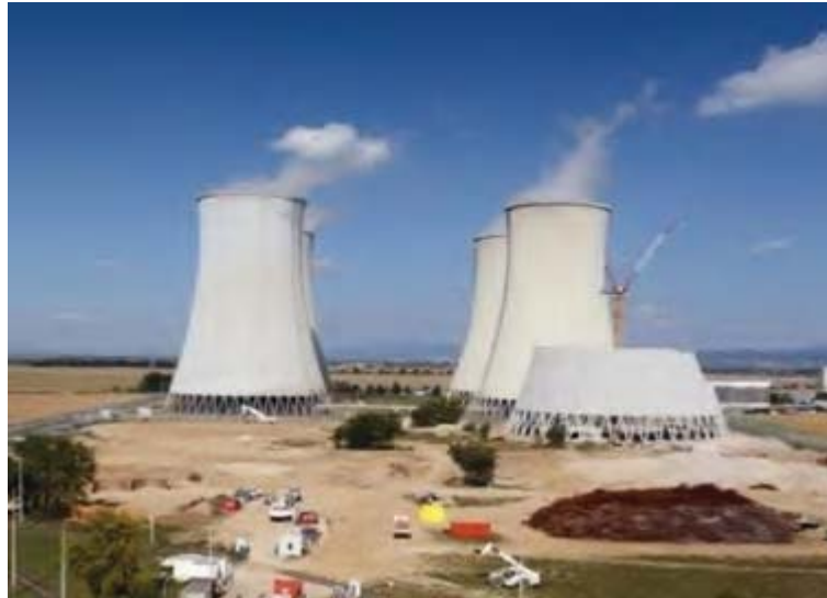
Abbildung 3 — Abriss der Kühltürme.
