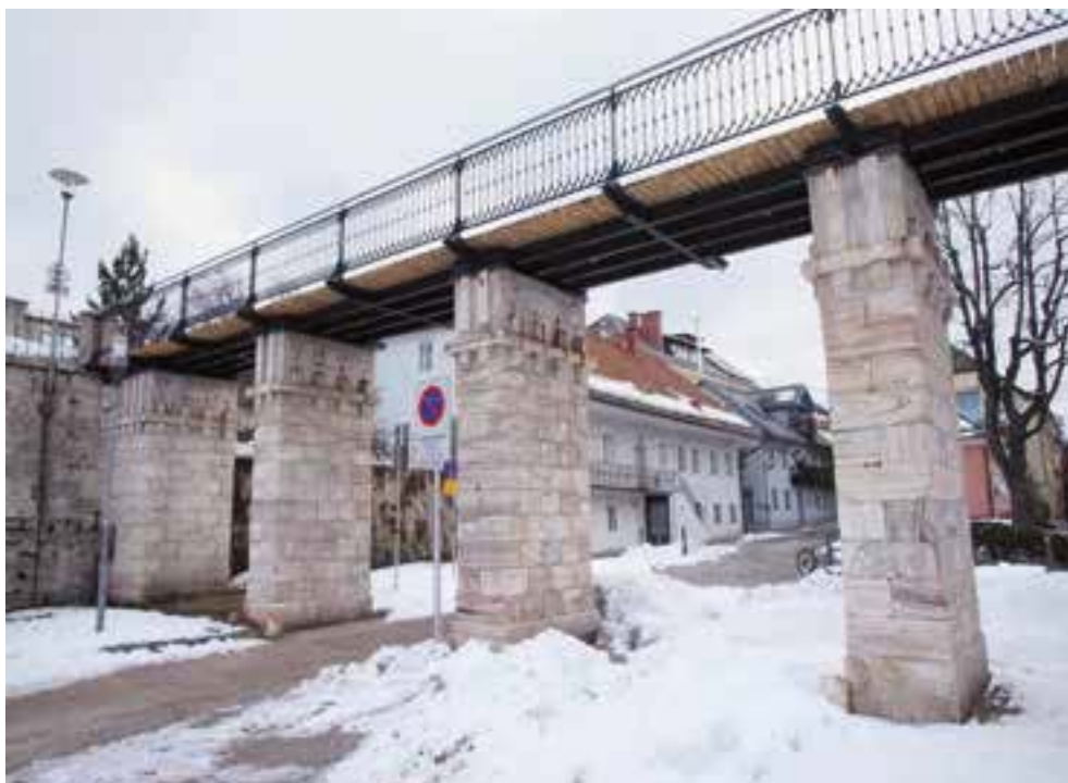
Klagenfurt, Elisabethbrücke nach Restaurierung
