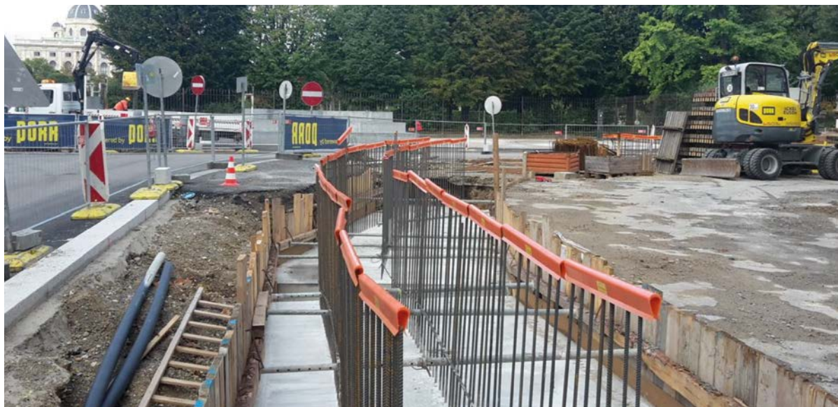
Abbildung 3: Fundament mit Bewehrungseisen im Bereich des Bundeskanzleramts zum Zeitpunkt des Baustopps
