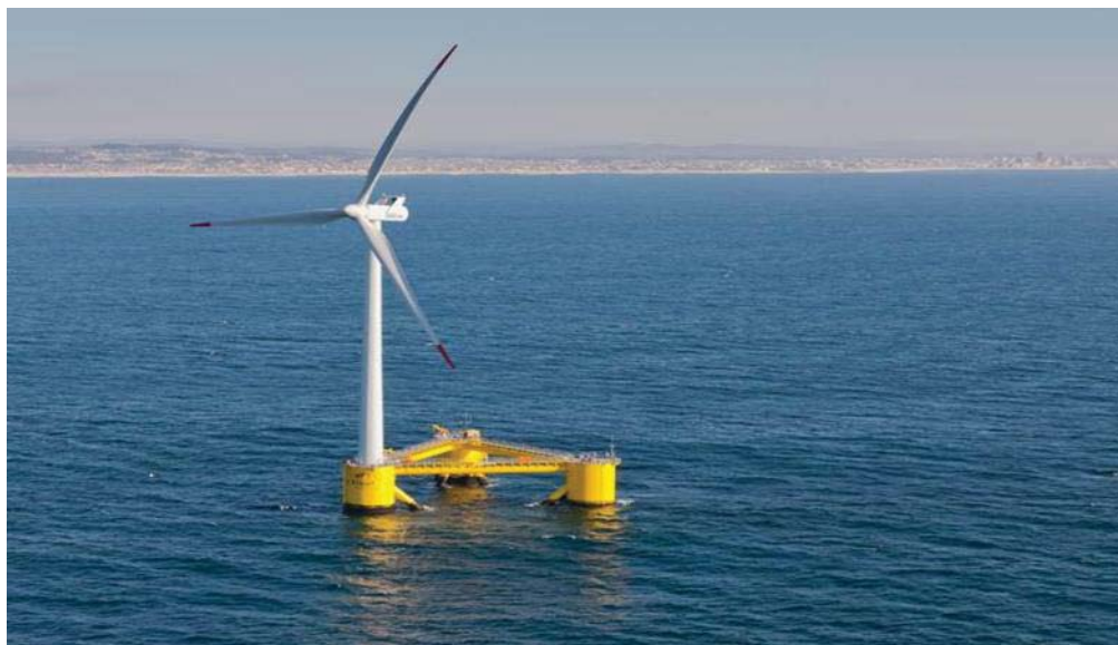
Projekt „Windfloat“, Portugal.
