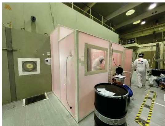
Ispra – Dekontaminierung heißer Zellen im LCSR
