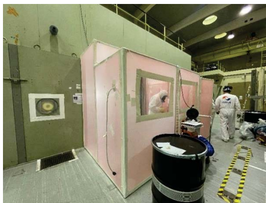
Ispra – Dekontaminierung heißer Zellen im LCSR
