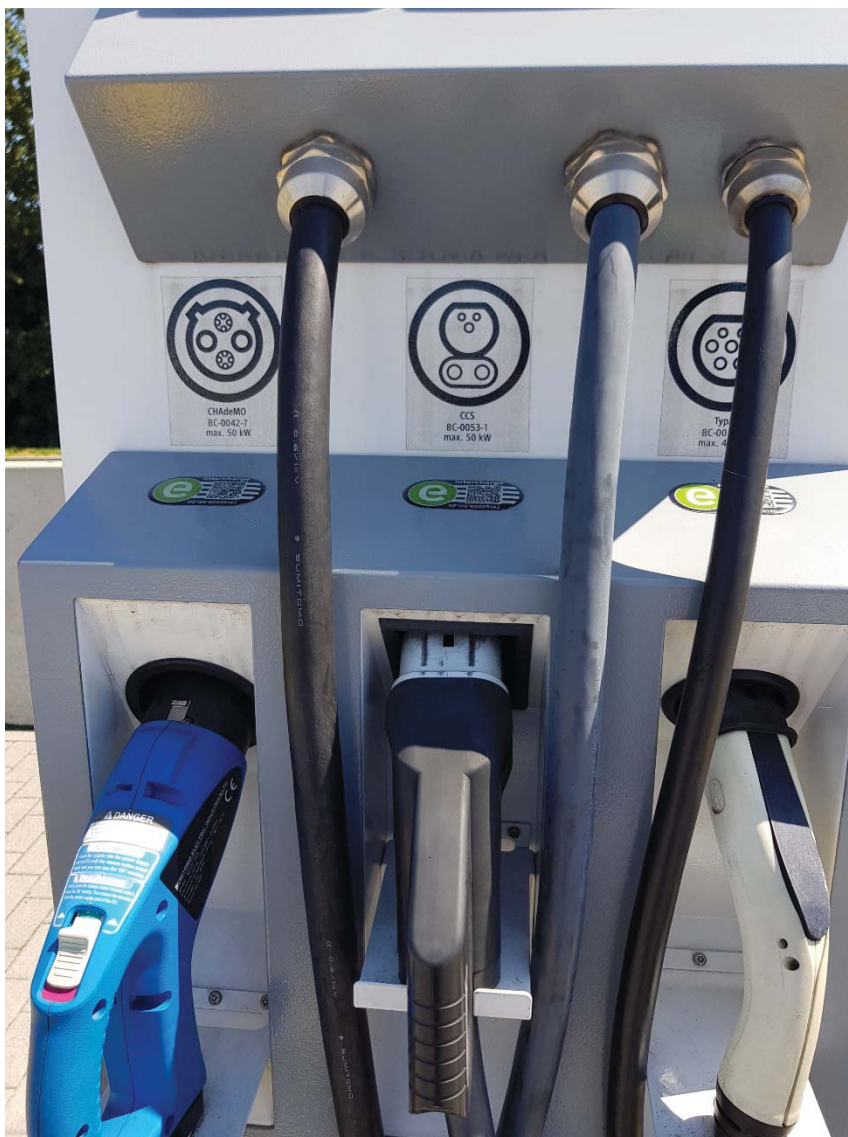
Bild 2 – Im Rahmen der CEF finanzierter Multistandardlader (CHAdeMO, CCS, Typ 2)
